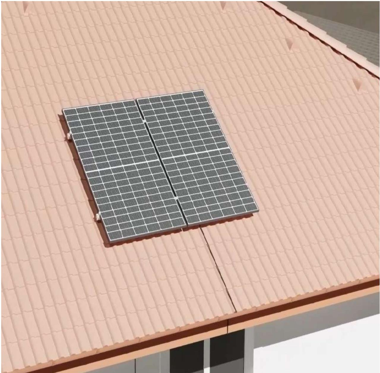
1. Bestimmen Sie einen geeigneten Ort auf Ihrem Dach und markieren Sie die Positionen an denen Sie die 6 Dachhaken montieren wollen.
