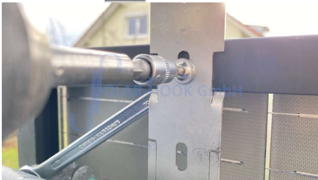
Abb. 18/Anziehen der kurzen Schrauben
