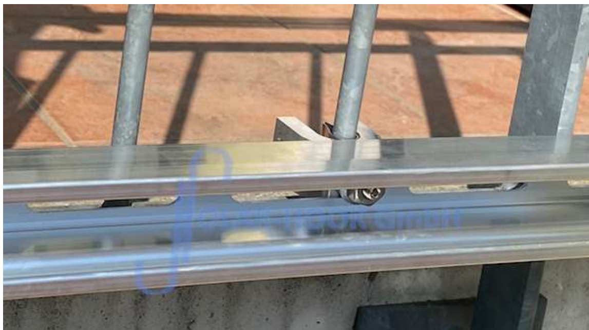
Abb.g 13/Montageschiene und Spezialklemme von außen
