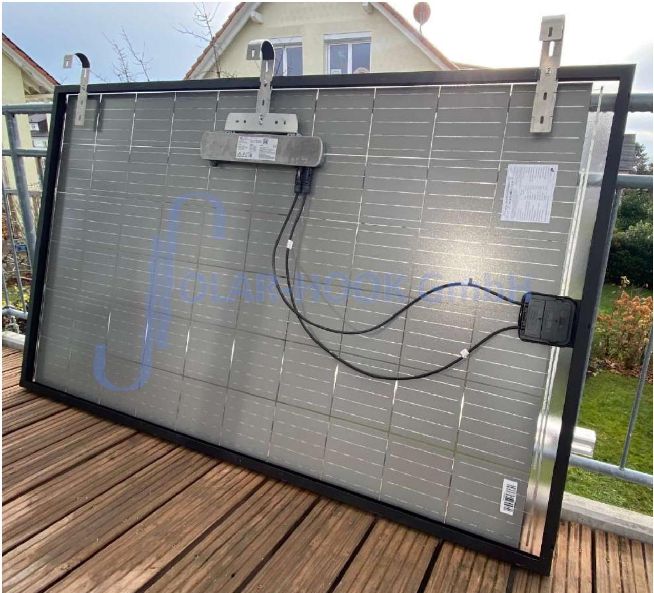
Abb.9/vorbereitetes Solarmodul mit 3 Befestigungsbügeln und Wechselrichter
