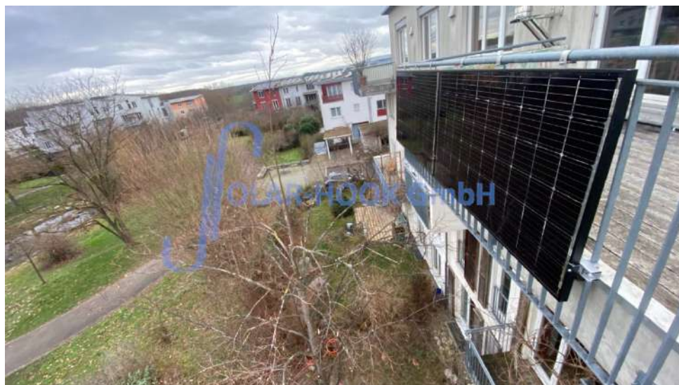
Abb. 20/Ansicht von außen
