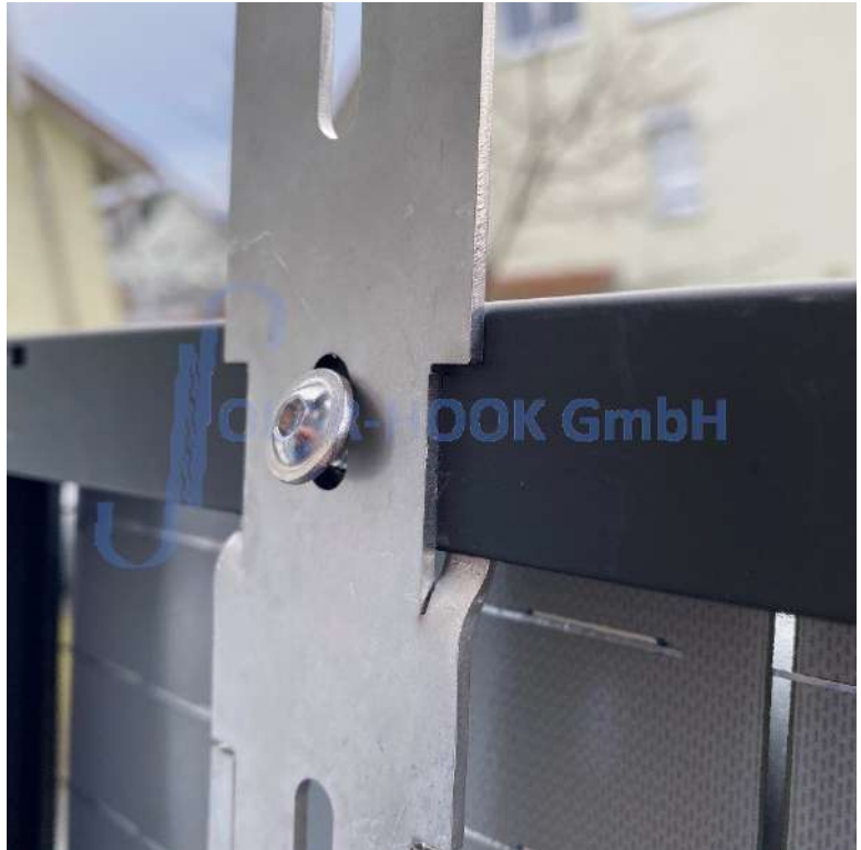
Abb. 6/locker angesetzte Schraube M6 kurz
