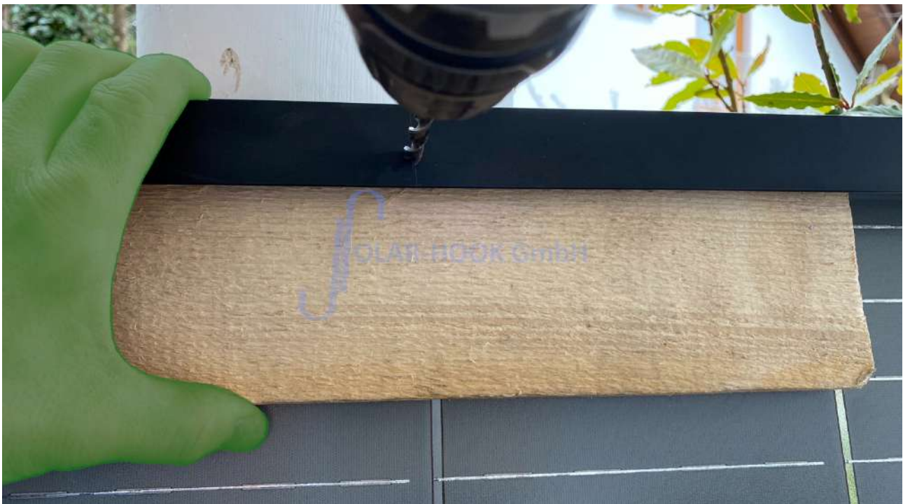
Abb. 8/dritte Montagebohrung
