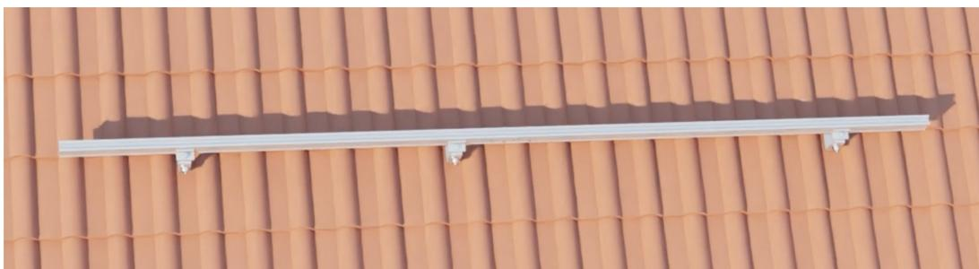
Wiederholen Sie diesen Vorgang für das zweite Schienenpaar. Richten Sie beide Schienenpaare in der Vertikalen parallel zueinander aus.
