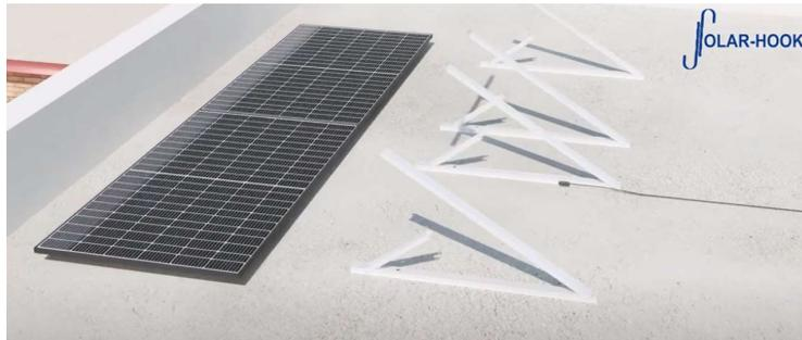
Positionieren Sie nun je 2 der 1450mm langen T-Verbinder auf der Basis der Dreiecke.
